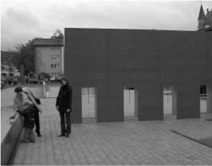
Die Aqwi-Tankstelle setzt einen markanten Akzent im Quartier.
