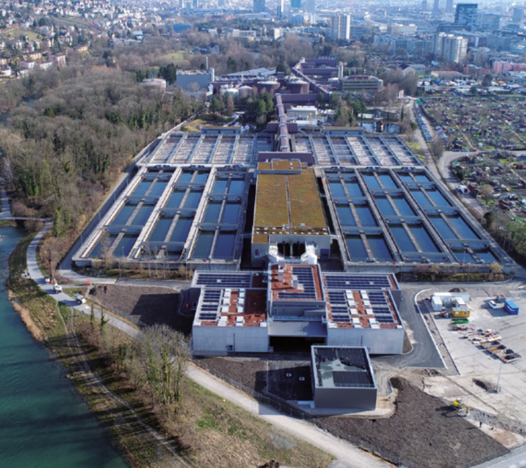
Abwasserreinigungsanlage Werdhölzli: hier wird das Abwasser auch aus dem Quartier Enge gereinigt, Quelle: ERZ
