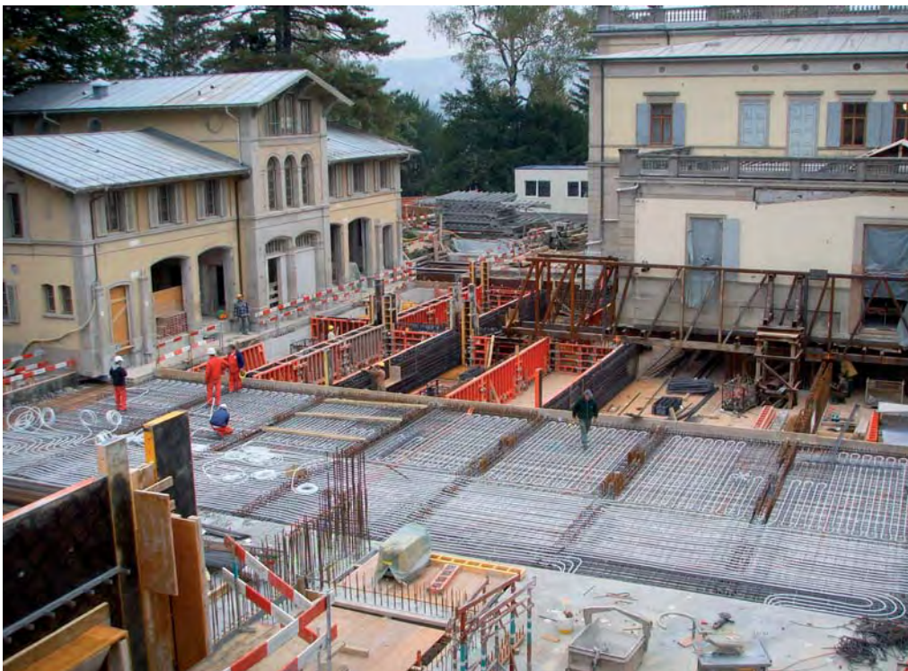
Vor Wintereinbruch ist die gewaltige Baugrube eingedeckt. Die Arbeiten am Erweiterungsbau des Museums Rietberg kommen planmässig voran.
